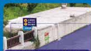
水位预警区域、水面检测
